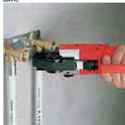
Прессовое соединение на монтажной шине
