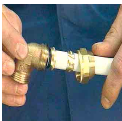
Труба „Coripe“ присоединяется к угольнику 90° „Cofit S“
