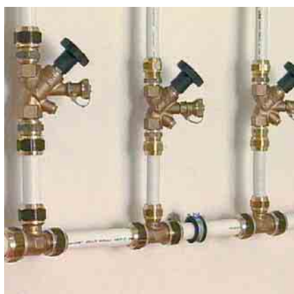
Монтаж арматуры с резьбовым соединением
